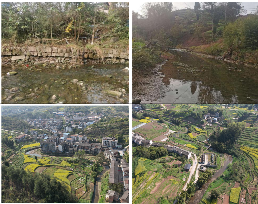
图 2-2 河道岸坡现状
